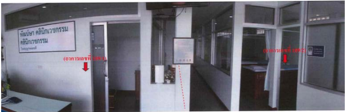
สภาพบริเวณภายในทรัพย์สินที่ประเมินมูลค่า (บริเวณห้องโถง ชั้นล่าง)
