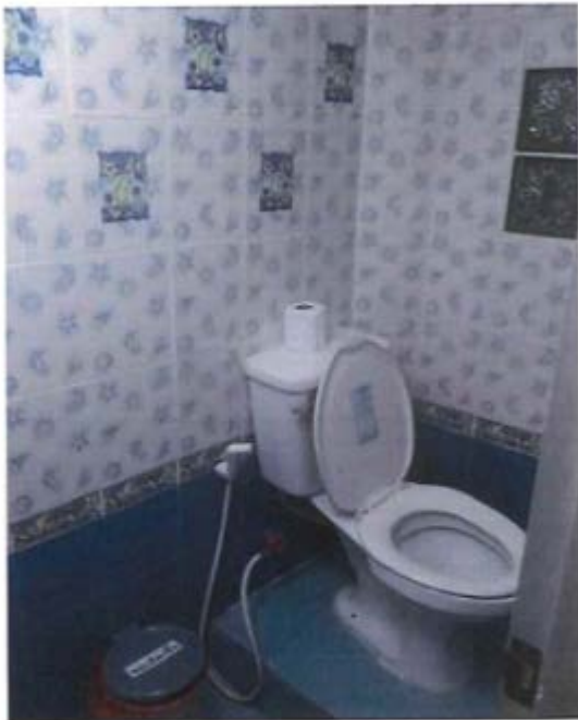
สภาพบริเวณภายในทรัพย์สินที่ประเมินมูลค่า (ห้องน้ำ ชั้นล่าง)
